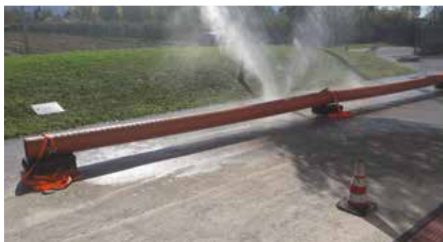
Pulizia effettuata con lavaggio ad alta pressione
