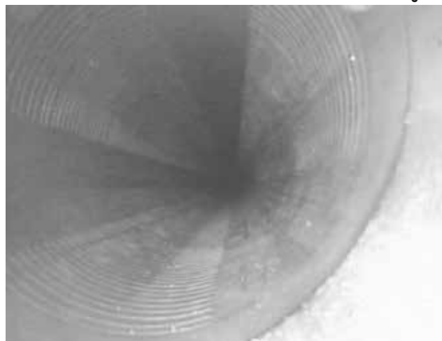
RIVESTIMENTO CON ECOPOZZO DOPO 5 ANNI DALL'INSTALLAZIONE
