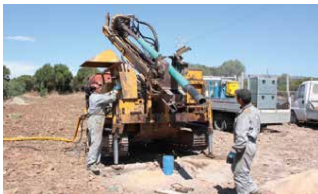
A sinistra: fasi iniziali di perforazione di un pozzo per acqua potabile.
